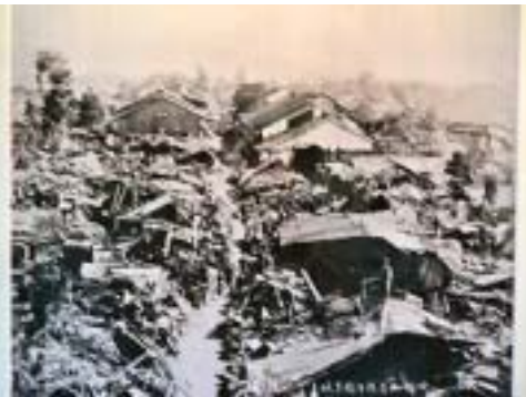
〔家屋の被災状況〕
